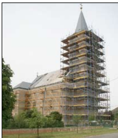
Megkezdődött a felújítás
